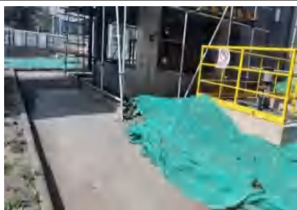
现场防尘网覆盖
