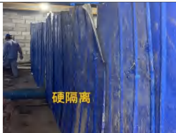
现场围挡设置
