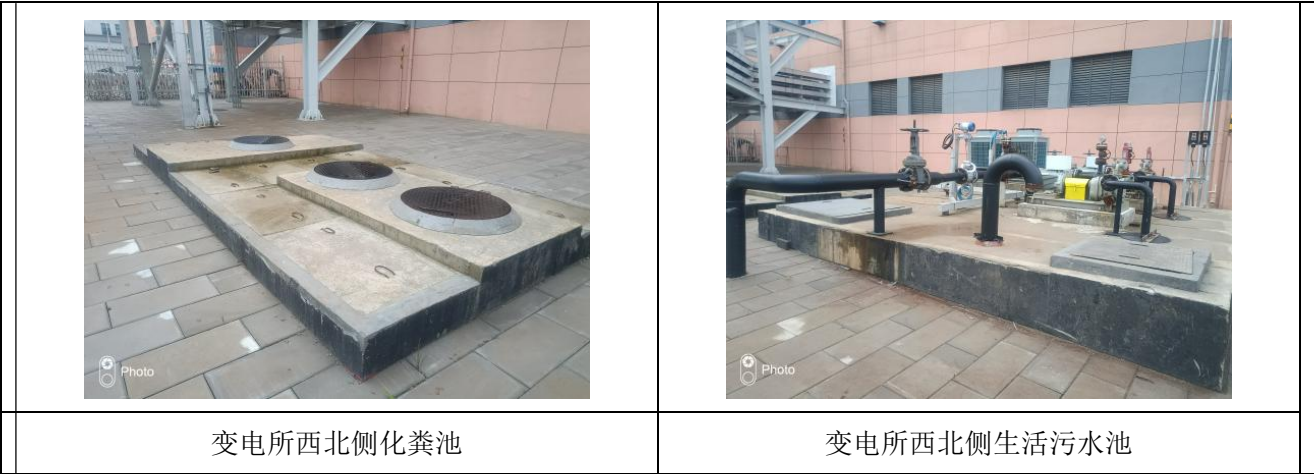
图 8-3 本工程变电所化粪池、生活污水池
