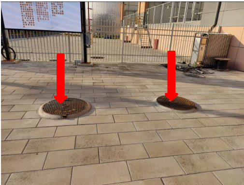
变电所东南侧事故油池
