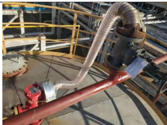
原 V-502A/B 呼吸阀加罩及软连接
