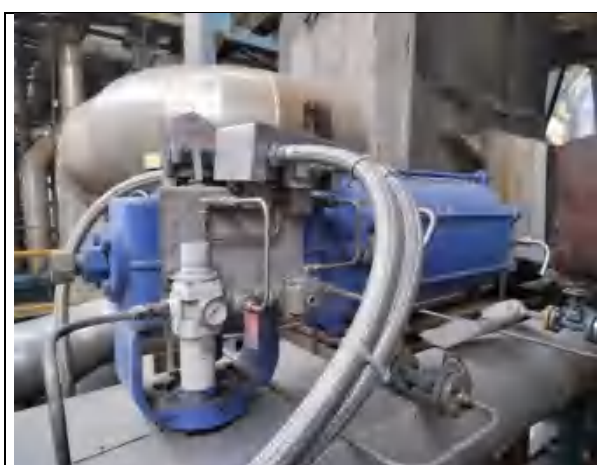
火炬气紧急切断阀
