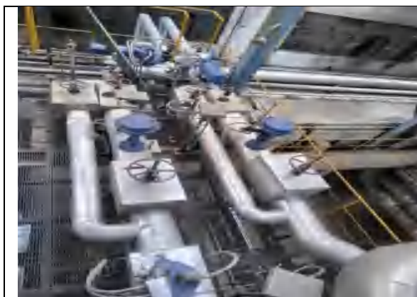
火炬气管线接 6#炉处
