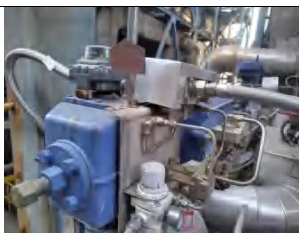
火炬气紧急切断阀
