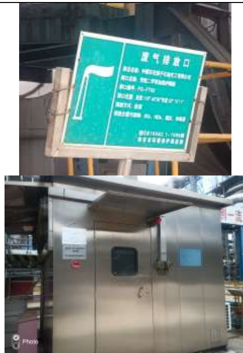
废气排放口标识和在线监测小屋
