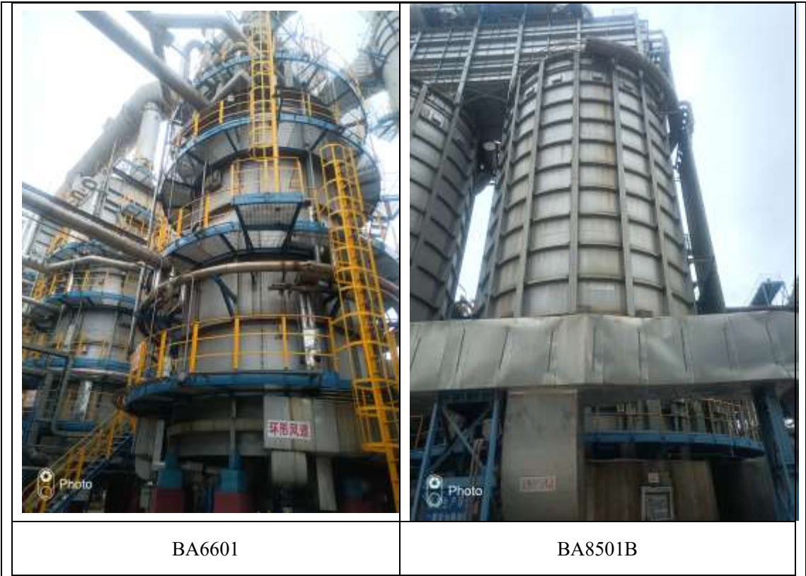
图 2-1 本项目建设内容现场照片
