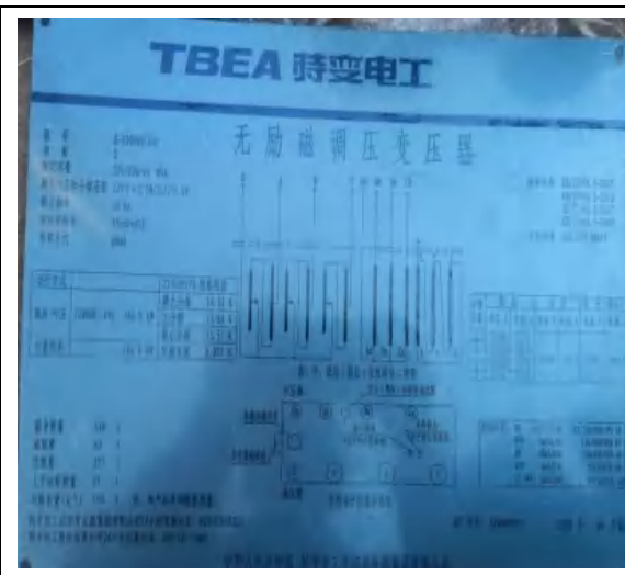
扬石变 13#主变（220kV/220MVA）铭牌
