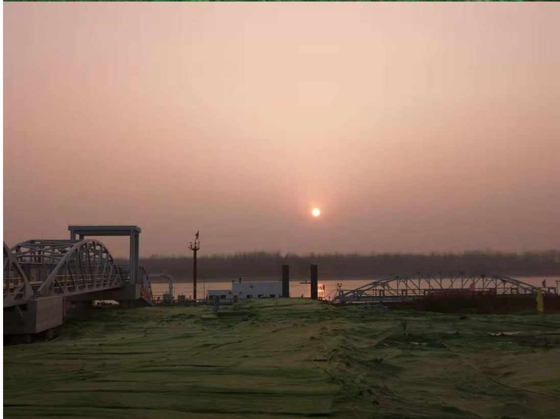
施工期防尘网铺设
