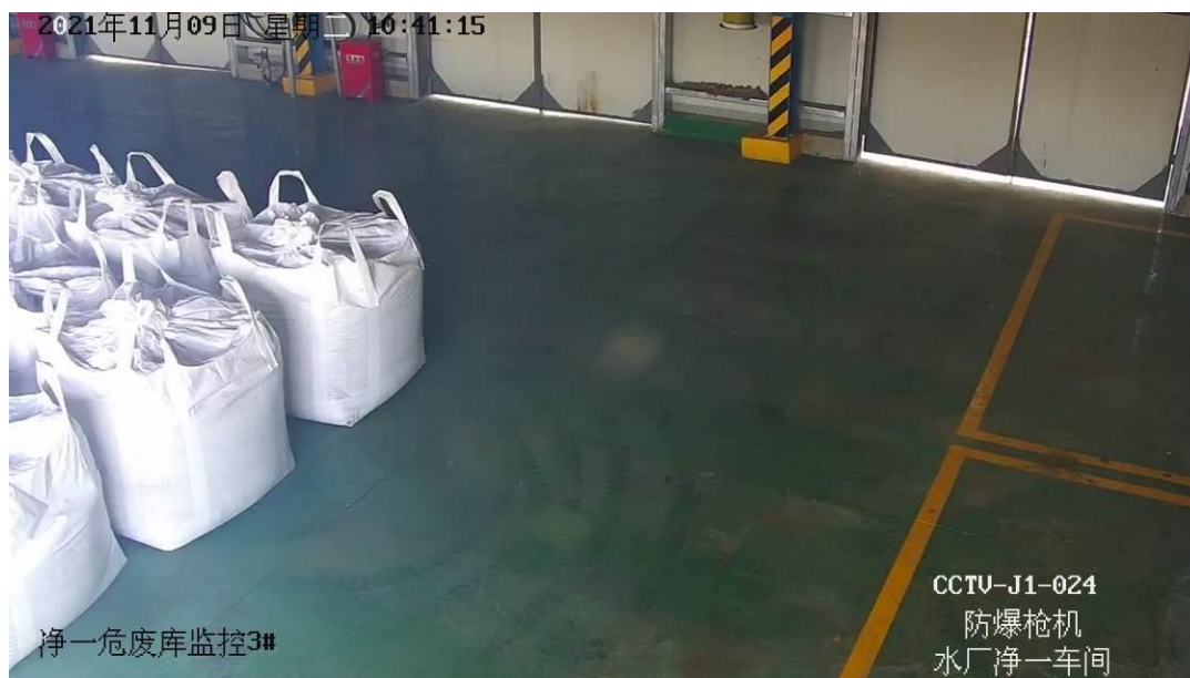
图 4.1-4 依托水厂净一装置危险废物中转库
