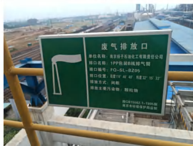
G5 排口标志牌 (5#排气筒) ; 排污许可证编号: DA017; 风量 (Nm 3 /h) : 12000; 高度 (m) : 24; 口径 (m) : 0.5; 温度 (°C) : 环境温度
