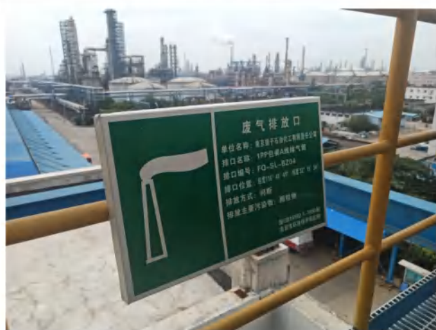
G4 排口标志牌 (4#排气筒) ; 排污许可证编号: DA018; 风量 (Nm 3 /h) : 12000; 高度 (m) : 24; 口径 (m) : 0.5; 温度 (°C) : 环境温度
