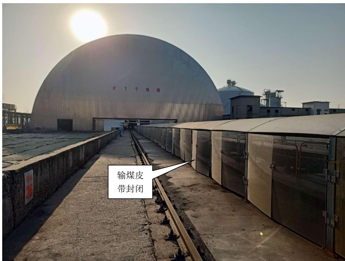
输煤皮带封闭
