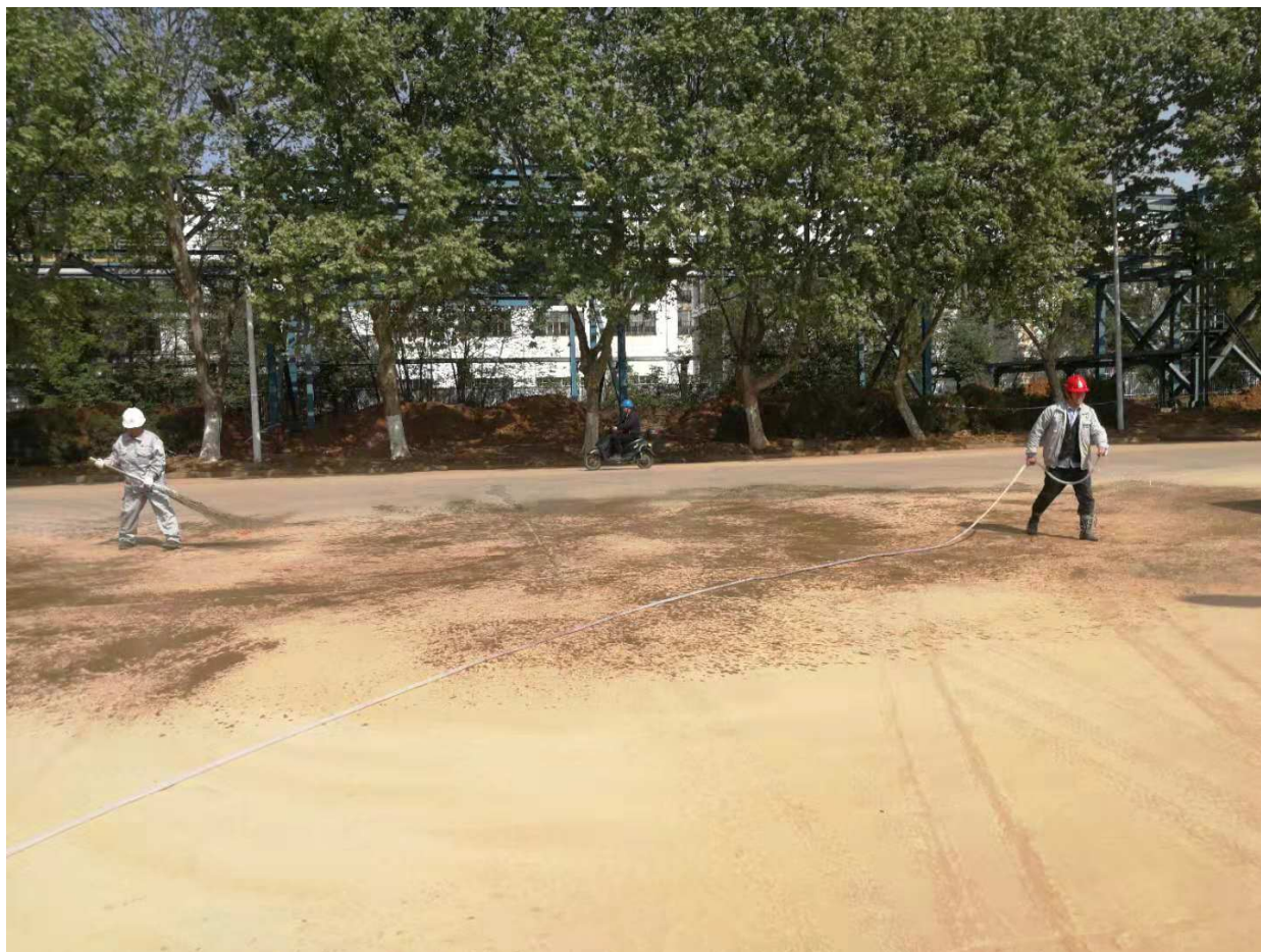
道路洒水养护
