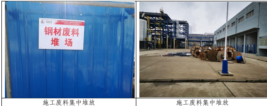
图 8.1-2 施工期间固废污染控制措施
