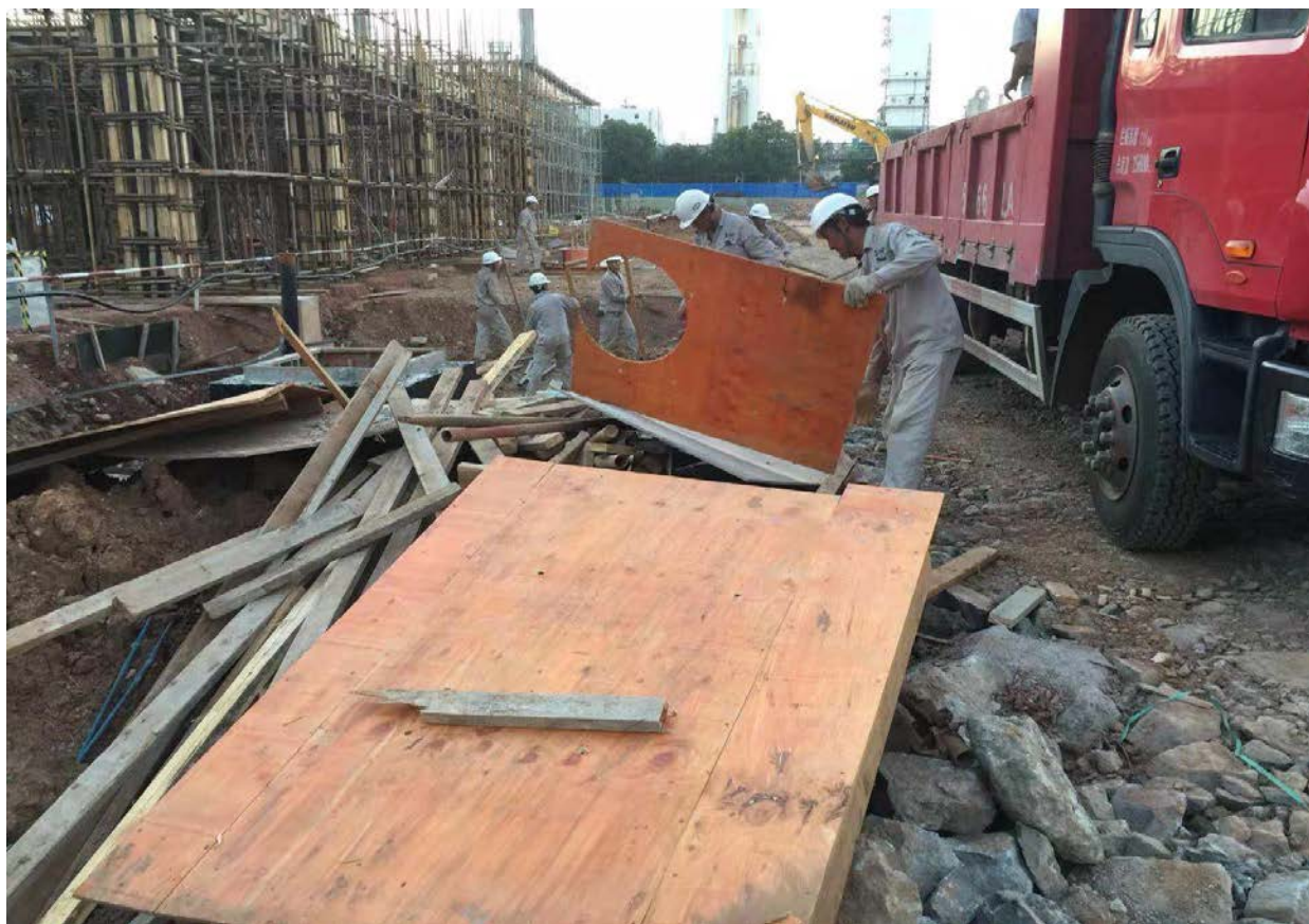
现场废料清理，分类摆放
