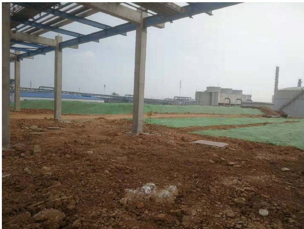
装置南侧土方平整，裸土覆盖
