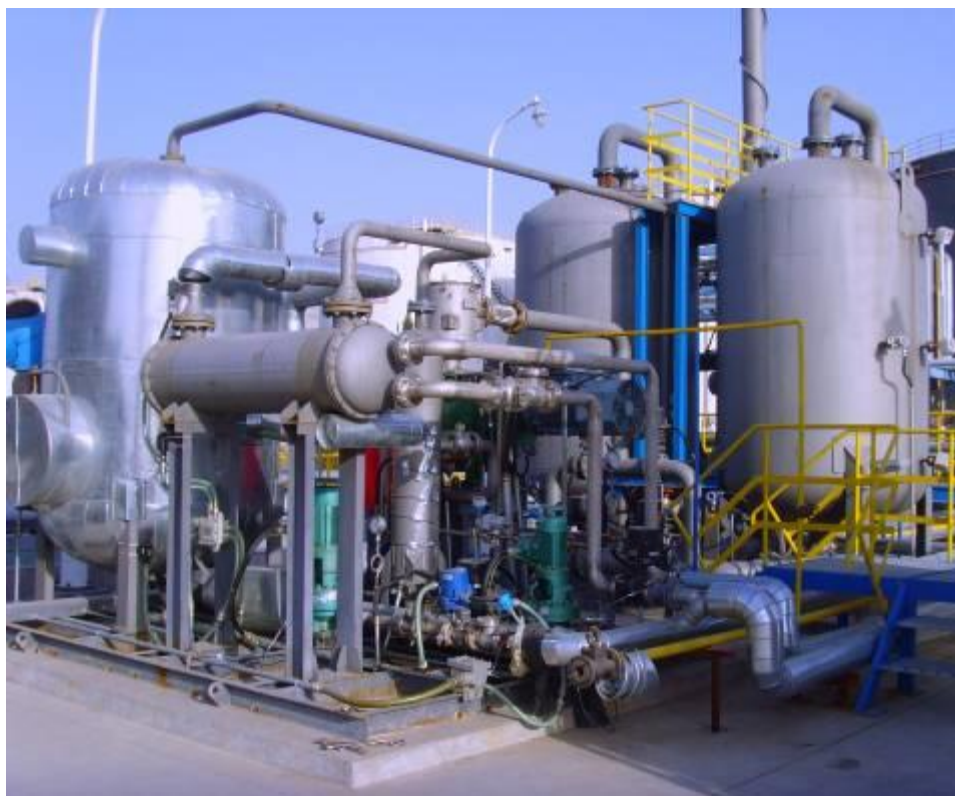
图 3.7-4 码头尾气回收装置
