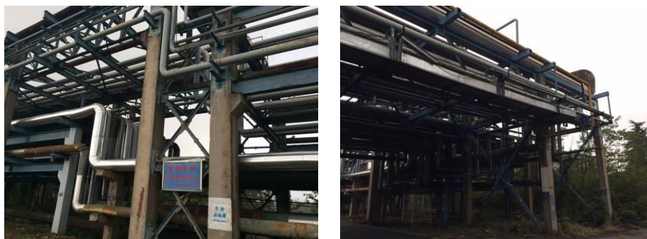
图 3.6-2 现有管廊照片
