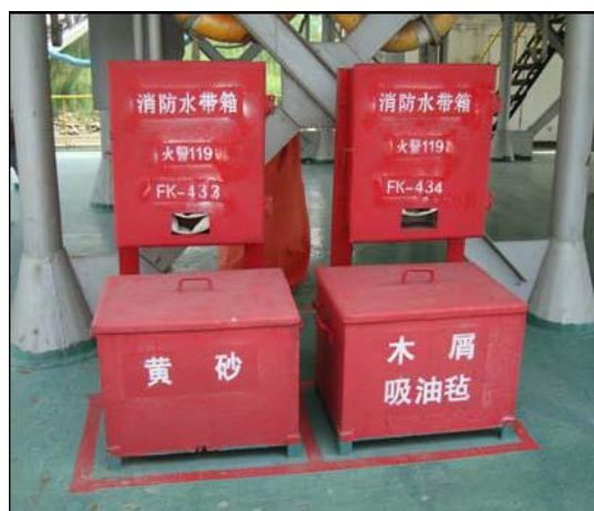
消防应急设备
