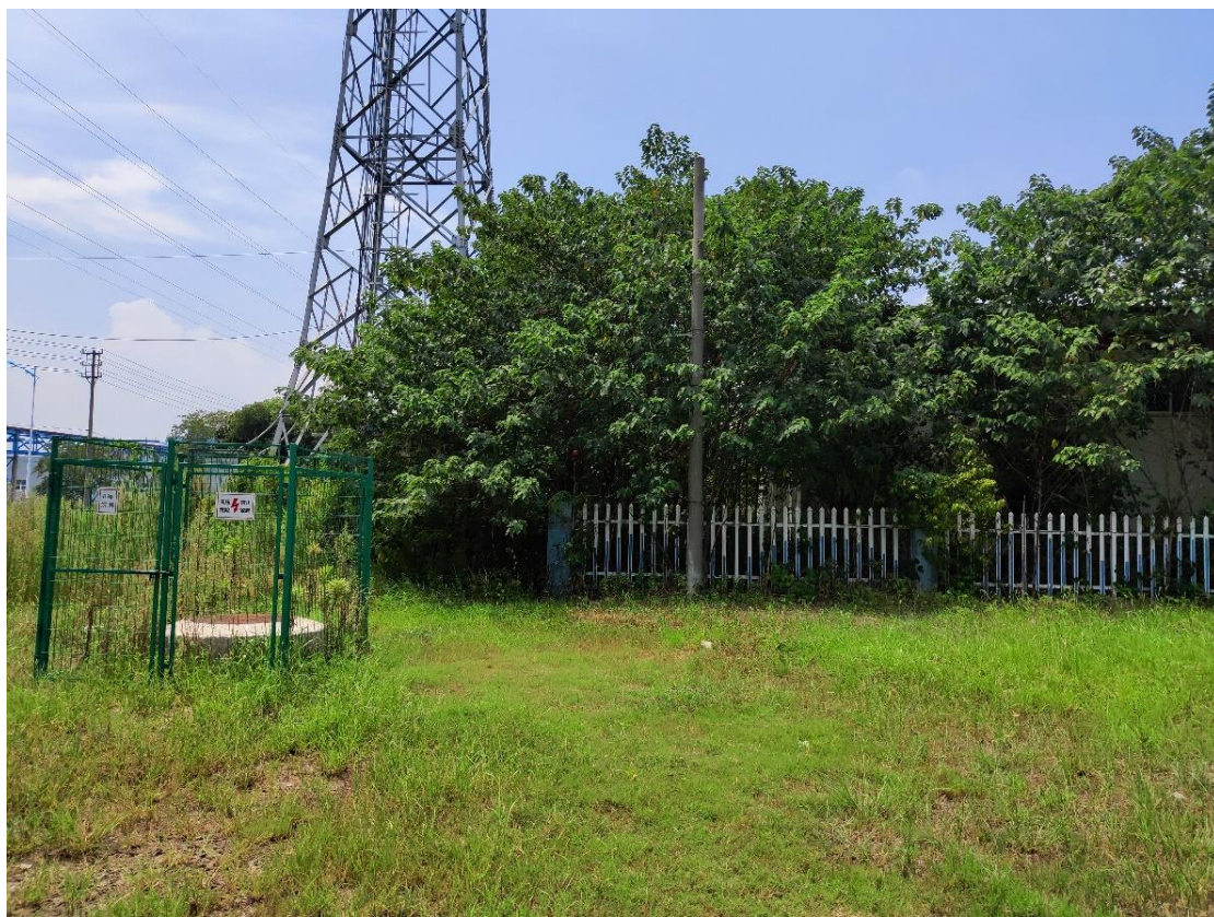
图 9 地下电缆周围的植被恢复
