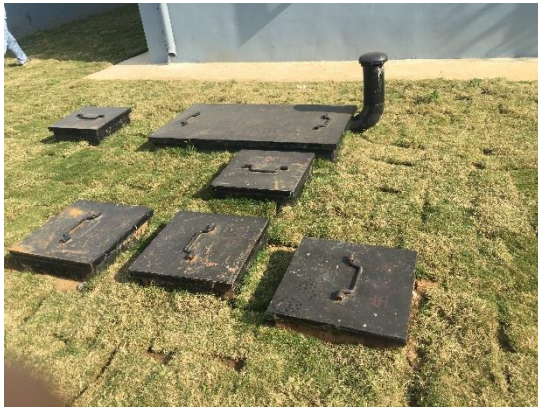
地埋污水处理设施
