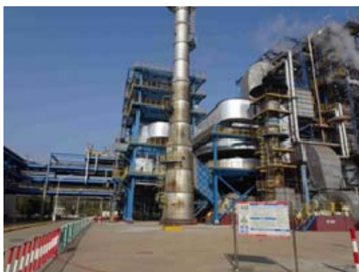
脱硝项目全貌
