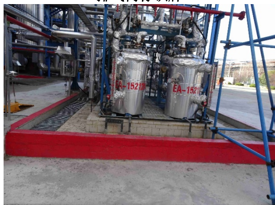
氨罐区围堰
