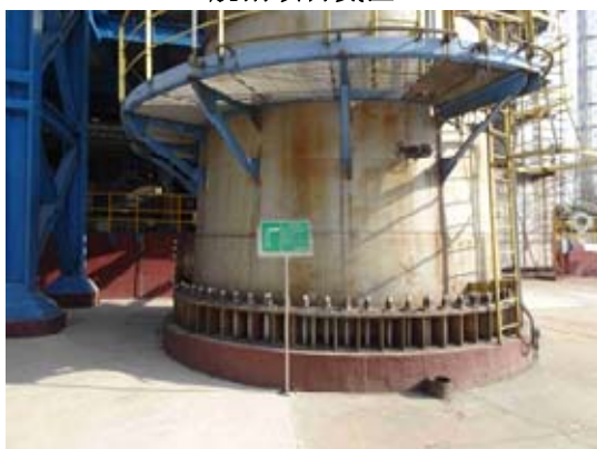
排气筒标识牌
