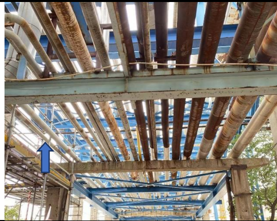
火炬路管廊照片（箭头所指位置为本项目位置）
