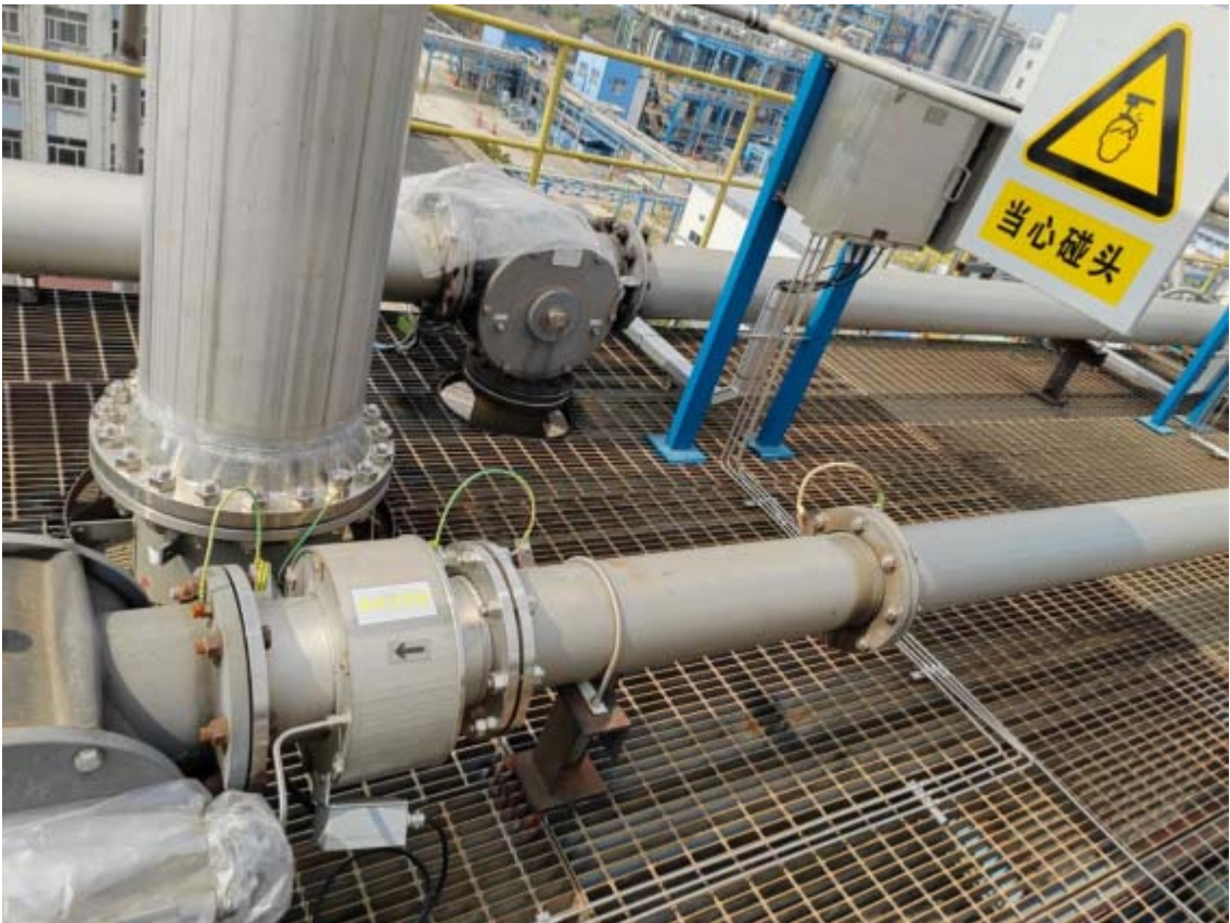
图 15 F502C 料仓静电监测消除系统仪表箱
