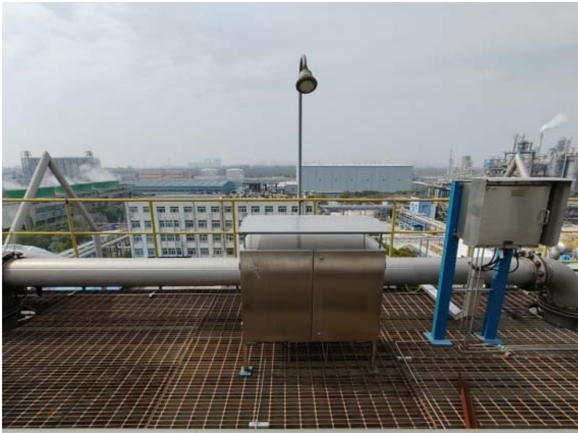
图 6 F502A/B 料仓在线可燃气体分析仪表箱
