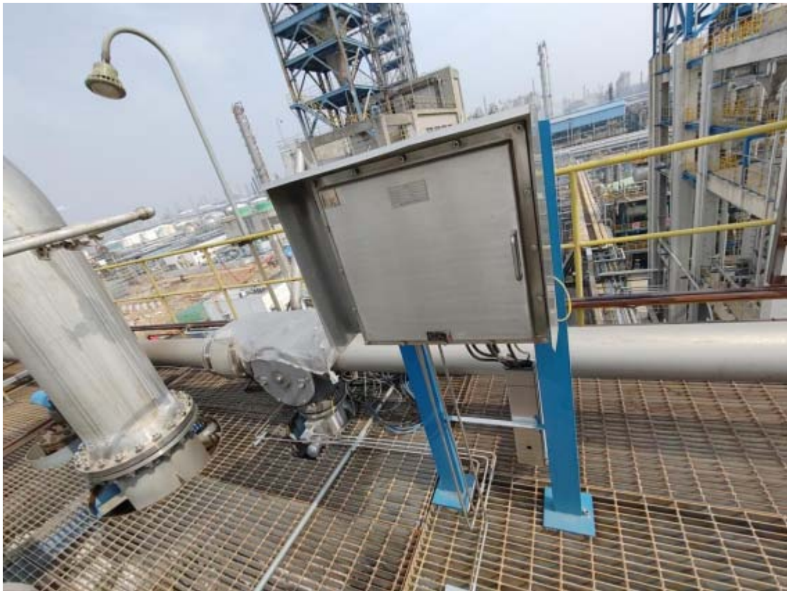
图 10 F502F 料仓静电监测消除系统仪表箱
