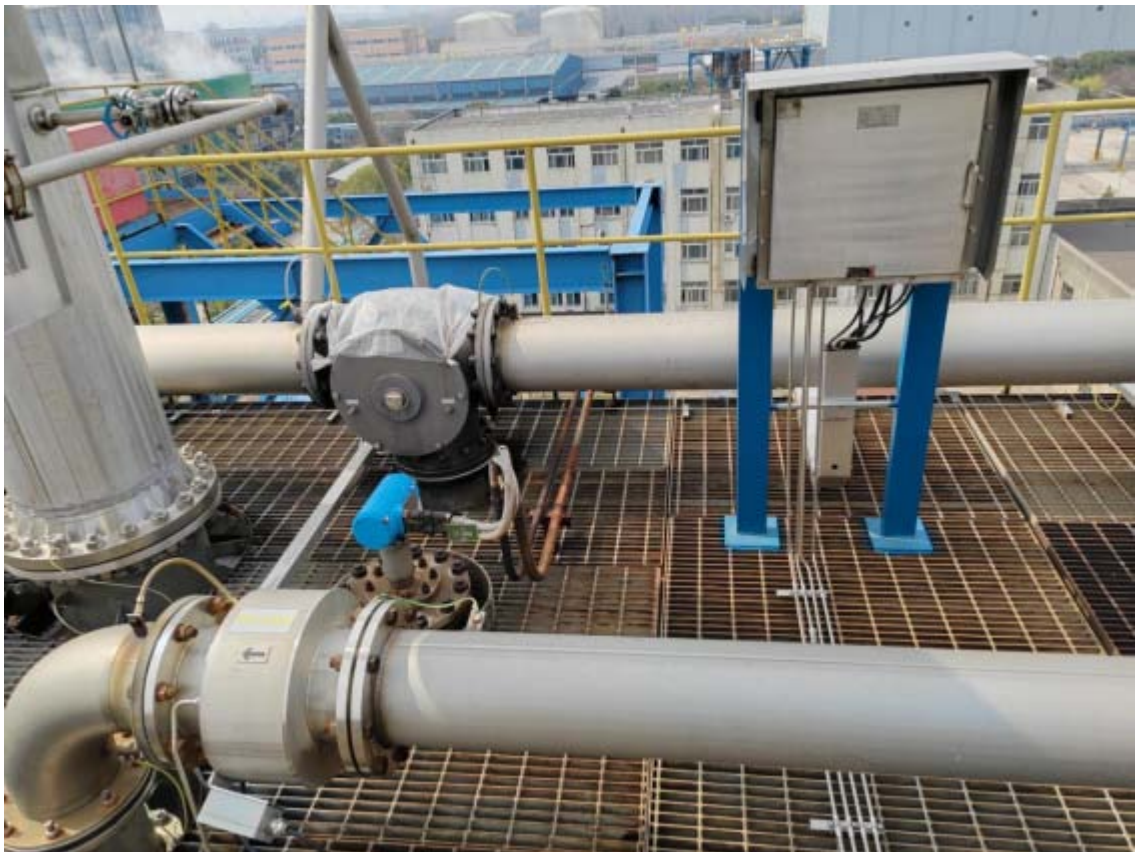
图 13 F502D 料仓静电监测消除系统仪表箱
