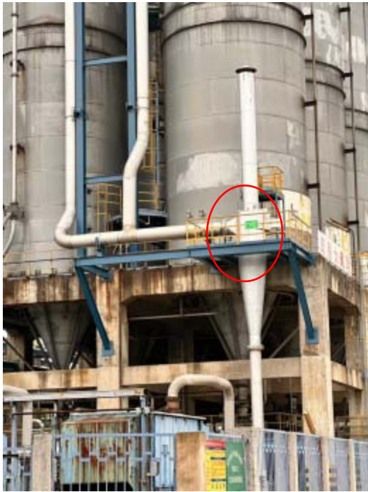
图 21 排气筒现场位置和监测口标识牌
