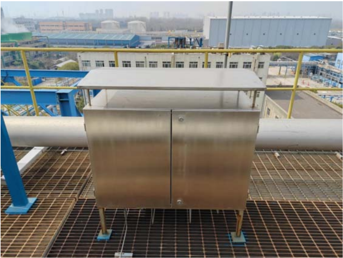
图 14 F502C/D 料仓在线可燃气体分析仪表箱
