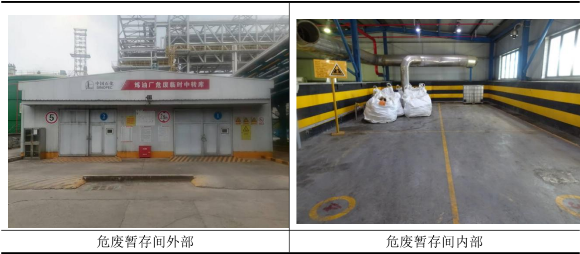
图 4-7 危废暂存间设置情况
